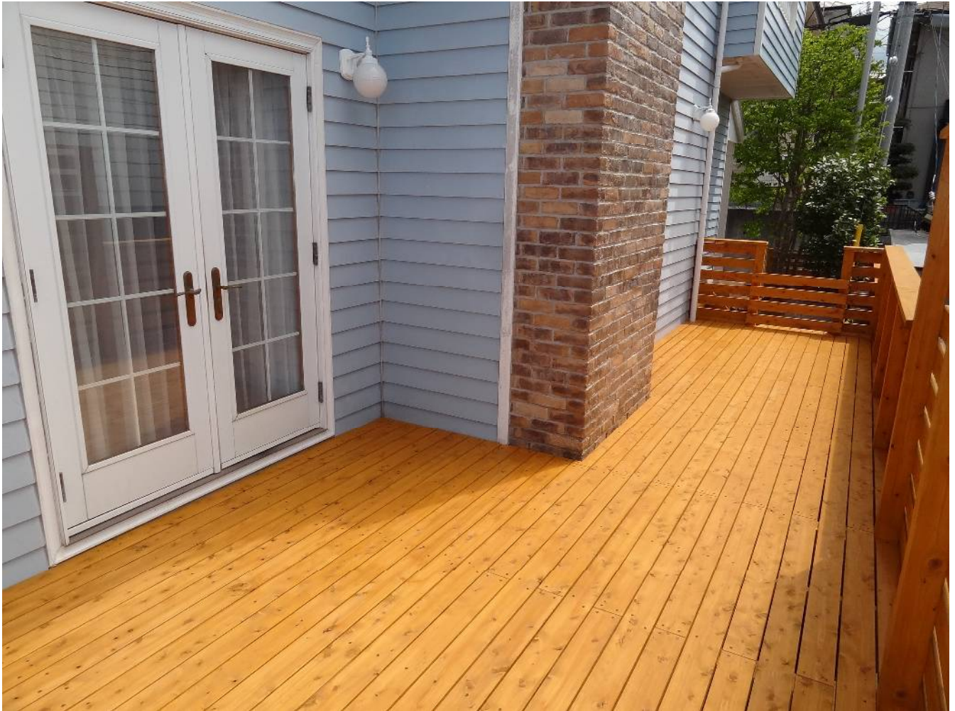
ウッドデッキリフォーム (ヒノキ材) ノンロット塗装仕上げ
