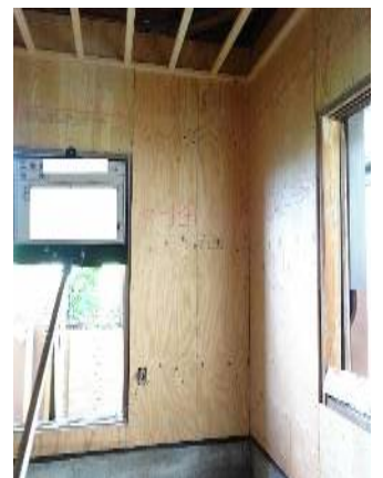
構造用合板張り
