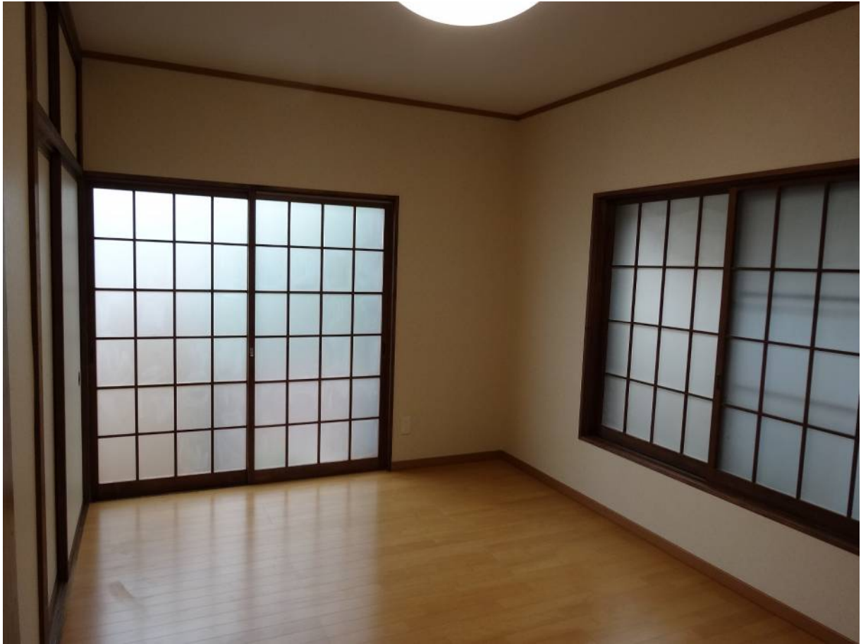
耐震補強工事にともない、床・壁・天井もリフォーム
