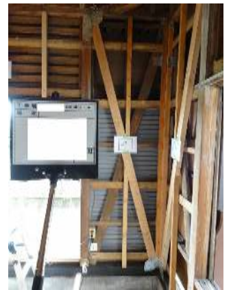
新設筋違取付け
