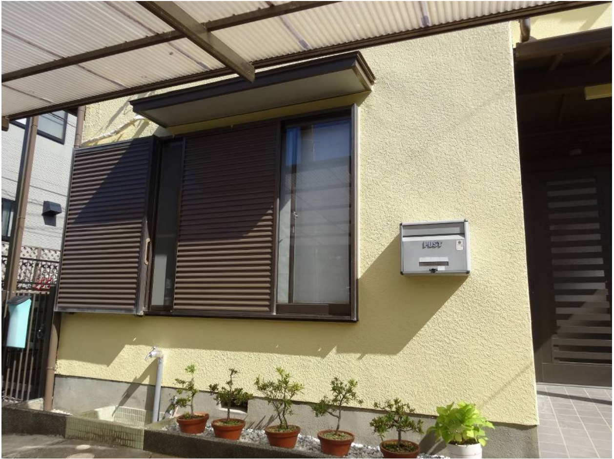
After (耐震補強工事完了後、外装塗装工事)
