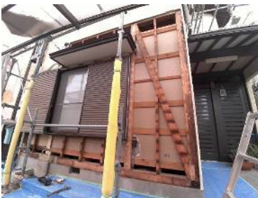
補強金物取付
