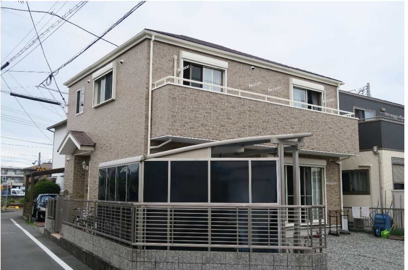
外装塗装リフォーム（屋根遮熱・壁クリヤー・付帯）
