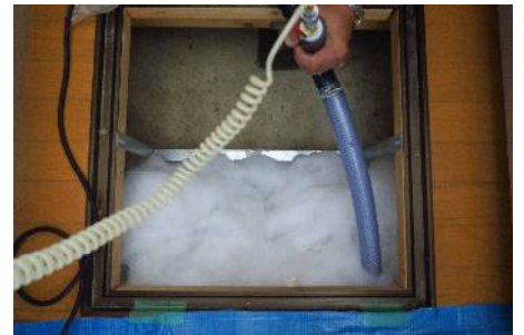
シロアリ防除工事（発砲）
