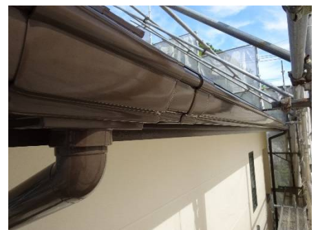
付帯塗装（雨樋）
