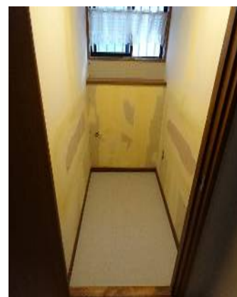
クロス下地 (パテ処理)
