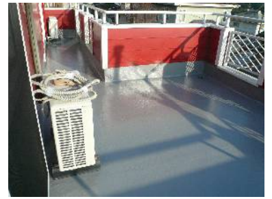
バルコニーFRP 防水
