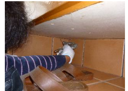
シロアリ防除（注入）
