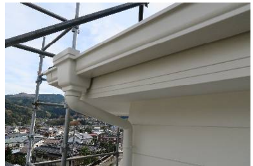
付帯塗装（雨樋）
